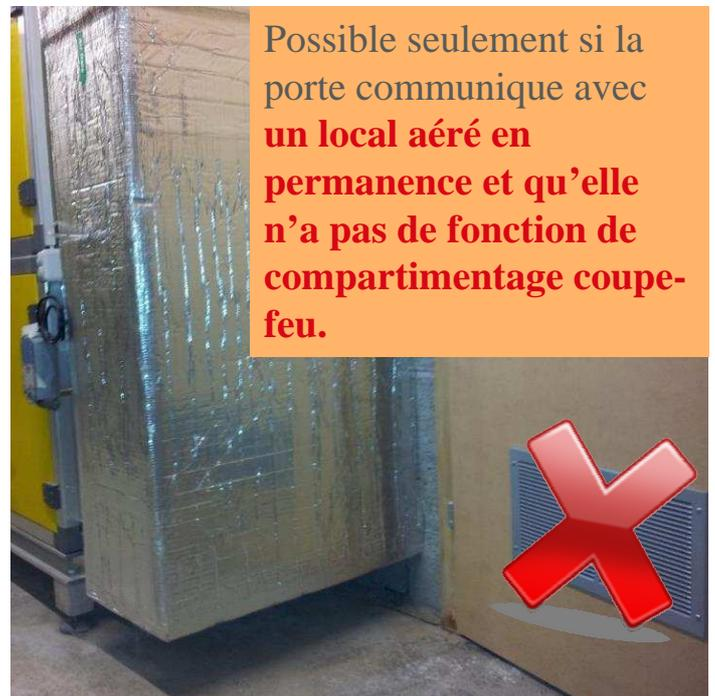
5. **Aucune ouverture** d'amenée d'air n'est requise dans les locaux d'implantation d'appareils de chauffage dotés d'un système **indépendant de l'air ambiant** (coaxial) prélevant l'air de combustion directement de l'extérieur.
